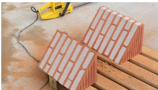
8.12 Schräg trocken geschnittener Ziegel.
