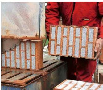
8.1 Schneiden mit der Nasssäge.
