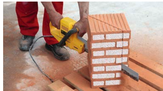
8.11 Trockenschneiden mit der elektrischen Handsäge.
