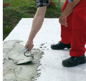
1.2 Im geplanten Wandbereich wird eine gleichmäßige dünne Mörtelschicht auf die Betonplatte aufgetragen.
