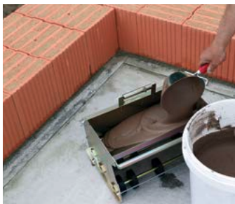
3.4 Jetzt wird die Mörtelrolle mit Dünnbettmörtel befüllt.
