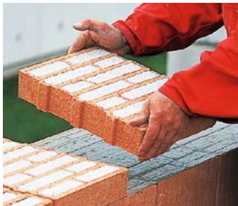
8.4 Versetzen des geschnittenen Ausgleichsziegels z. B. im Bereich einer Fensterbrüstung vermeidet Wärmebrücken.
