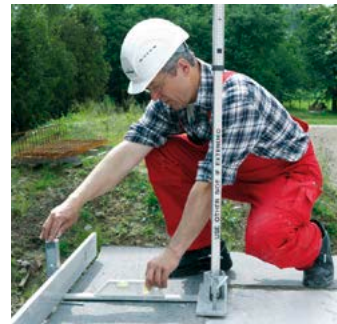
1.5 Den Justierboy (siehe Produktprogramm Wienerberger) aufbauen.
