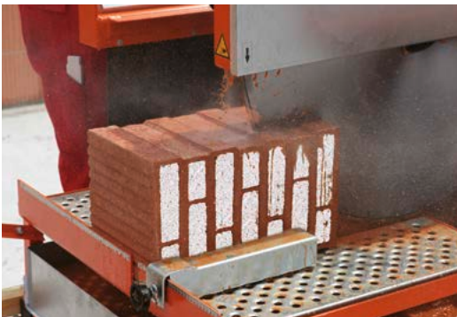
5.1 Höhenausgleich: Ausgleichsziegel mit der Nasssäge schneiden.
