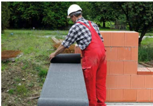
14.1 Bei Arbeitsende alle Mauerkronen abdecken.
