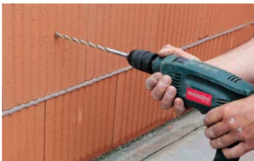
10.5 Bohren ohne Schlagfunktion mit scharf angeschliffenem Hartmetallbohrer.
