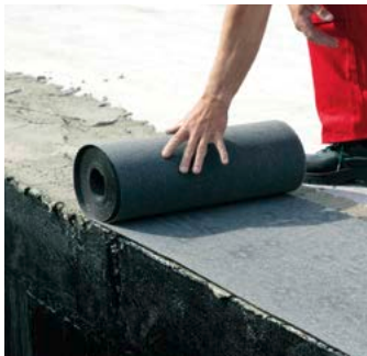
1.3 Damit keine Feuchtigkeit aufsteigt, wird in das Mörtelbett eine Sperrschicht (z. B. besandete Bitumenbahn) eingebettet.
