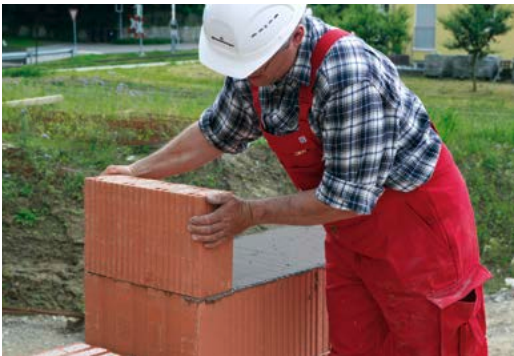
7.1 Für eine optimale Laibungsbildung stehen spezielle Laibungsziegel zur Verfügung.
