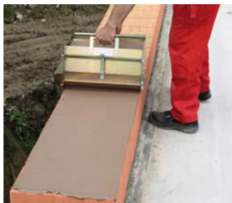
3.5 Mörtelrolle aufsetzen und ohne Druck über die Ziegel ziehen. So wird der Dünnbettmörtel schnell und einfach auf die Ziegelschicht aufgetragen.
