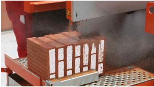
8.6 Mit der Nasssäge können Ausgleichziegel in beliebiger Höhe geschnitten werden.
