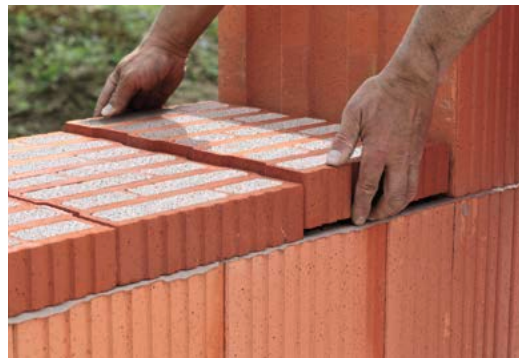
5.2 Ausgleichsziegel z. B. im Bereich einer Fensterbrüstung vermeiden Wärmebrücken.
