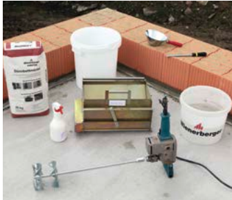
3.1 Benötigtes Material (gem. Wienerberger Produktprogramm): Dünnbettmörtel, Reinigungsspray (Trennmittel), Anrühreimer, VD-Mörtelrolle, Wassereimer, Doppel-Rührquirl, Schöpfkelle, Feile.
