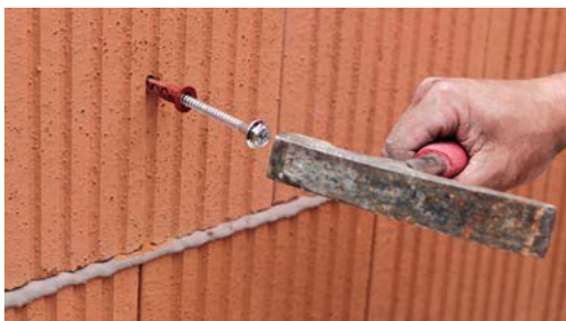
10.7 Dübel mit Hammer bündig einschlagen.
