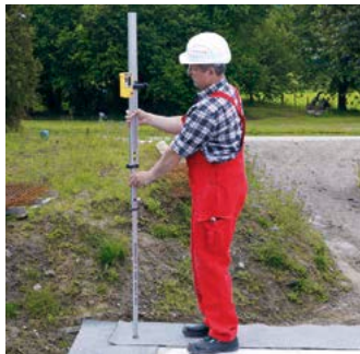
1.4 Um die Mindesthöhe der Mörtelschicht festzulegen, wird mit einem Nivelliergerät oder einer Schlauchwaage der höchste Punkt der Betonplatte ermittelt.
