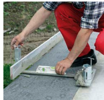
1.8 Danach eine Abziehlehre um Richtlattenlänge versetzen und neu justieren.
