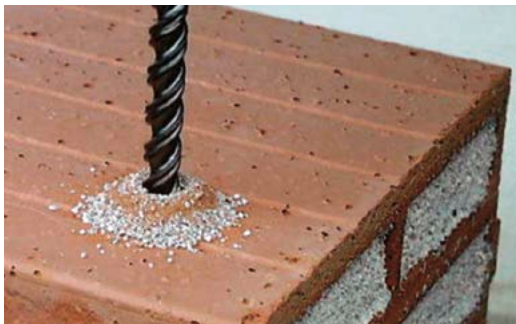
10.4 Perlitgefüllte Ziegel bohren.
