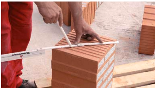
8.10 Sowohl für die Nasssäge als auch für die Handsäge werden die Schnitte angezeichnet.
