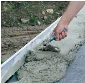
1.6 Vor dem Richtschieben Mörtel verteilen.
