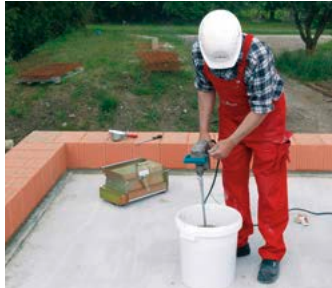
3.2 Dünnbettmörtel wie auf dem Mörtelsack angegeben mischen und anrühren.
