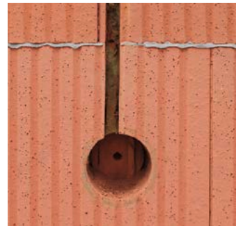
10.3 Das fertige Loch für eine Steckdose.
