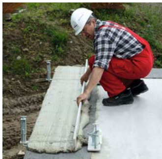
1.7 Mit dem Richtschieben den Mörtel auf den horizontalen Abziehlatten des Justierboys planeben abziehen.
