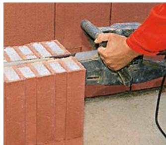
8.2 Trockenschneiden mit der elektrischen Handsäge (Alligator).
