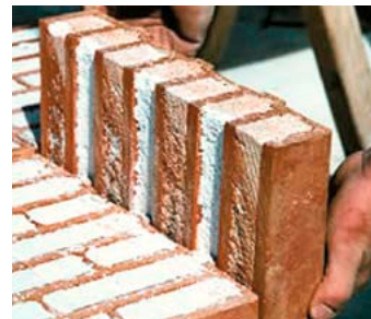
8.3 Ausgleichsziegel werden ohne Wärmebrücken versetzt.
