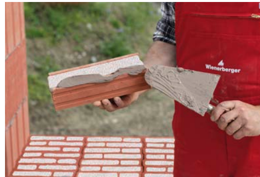
7.2 Die wärmegeämmte Poroton-Anschlagshale wird mit Dünnbettmörtel bestrichen ...
