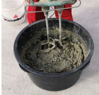
1.1 Anmischen des Mörtels (MG III) nach Herstellerangaben.
