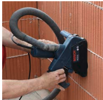
10.2 ... vertikales Schlitzen für Elektrodosen.
